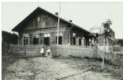
Stará škola a výstavba nové školy na Gruni v roce 1931
